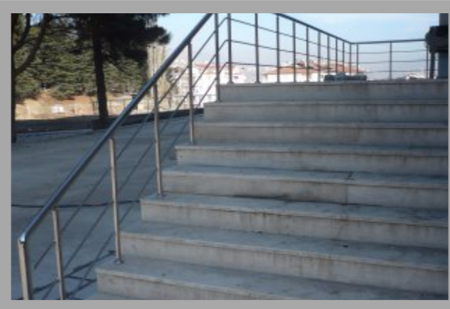
Dış mekan 3 emniyet kayıtlı üstten bağlantılı korkuluk uygulaması
