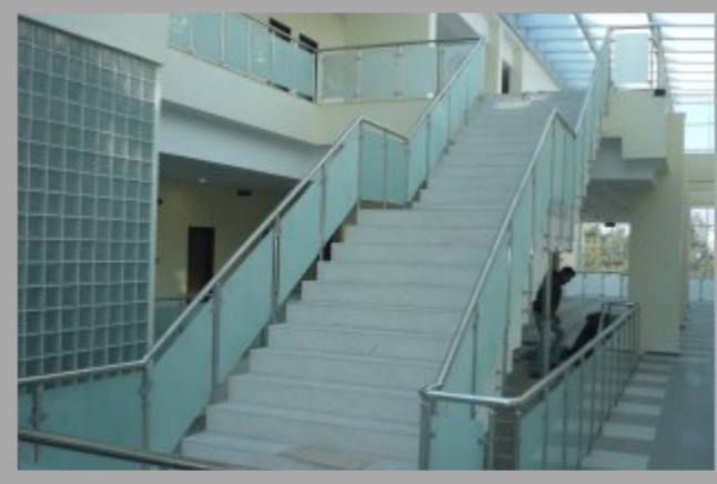
5+5 lamine temperli kumlu cam, merdivenler yandan bağlantılı, galeri boşlukları üstten bağlantılı korkuluk uygulaması
