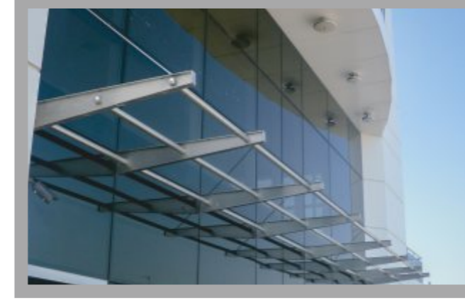
13 metre uzunluğunda 10 mm lama ayaklı sundurma uygulaması
