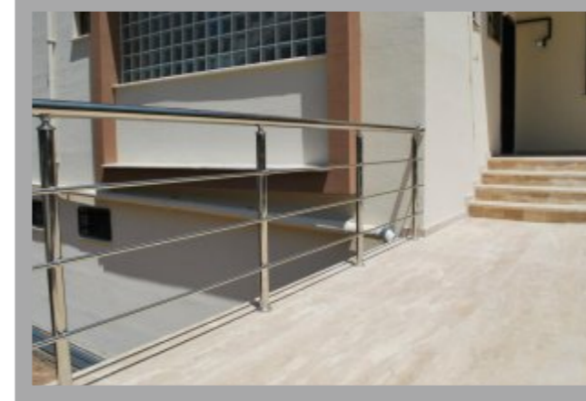
İç mekan merdiven 3 emniyet kayıtlı üstten bağlantılı korkuluk uygulaması
