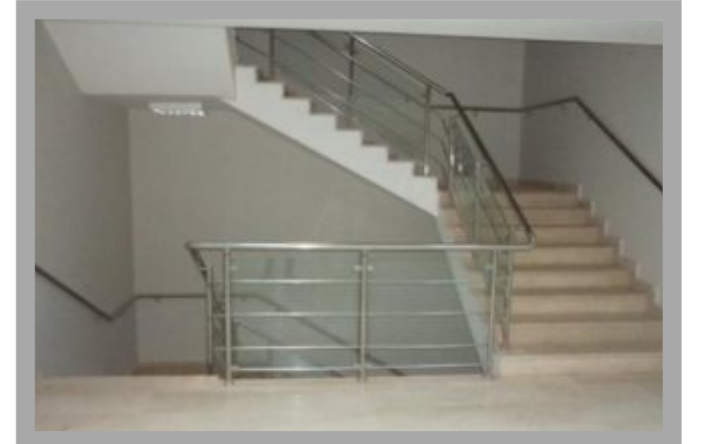
5+5 lamine camlı, Q14'lük konsol küpeşte bağlantılı, 3 emniyet kayıtlı, üstten bağlantılı korkuluk uygulaması
