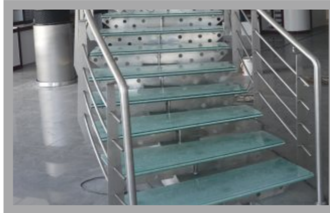
10+10+10 temper+lamine cam basamaklı omurga merdiven uygulaması
