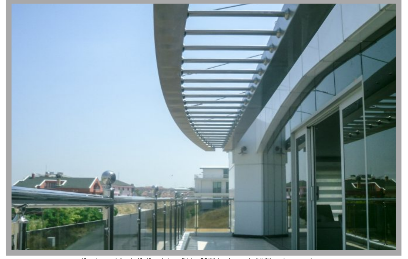
13 metre uzunluğunda 40x40 cm kutu profil içine Q51'lik boruların yerleştirildiği sundurma uygulaması
