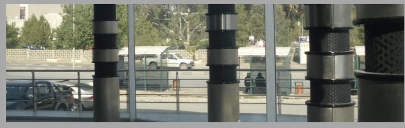
Paslanmaz kolon kaplama uygulaması
