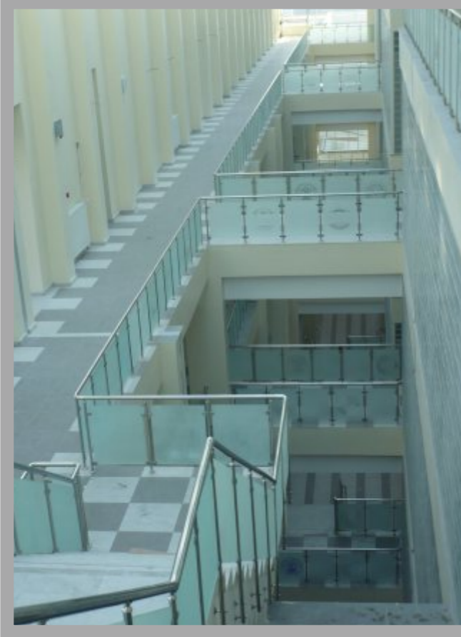
5+5 lamine temperli kumlu cam, merdivenler yandan bağlantılı, galeri boşlukları üstten bağlantılı korkuluk uygulaması
