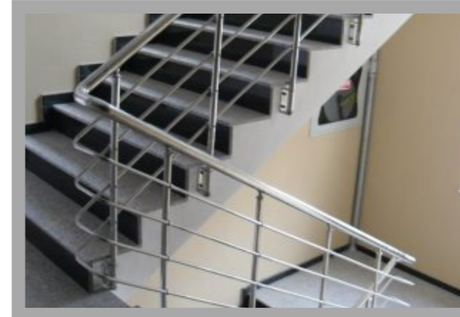
Merdiven Q14'lük konsol küpeşte bağlantılı ,3 emniyet kayıtlı, ve yandan ankaraj bağlantılı korkuluk uygulaması
